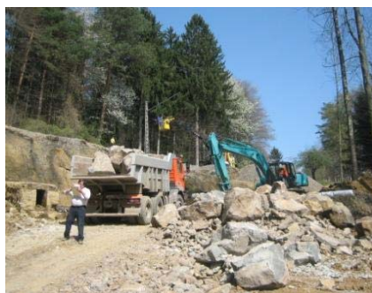
Bauarbeiten im Bereich Oedt, die nun beendet wurden.
